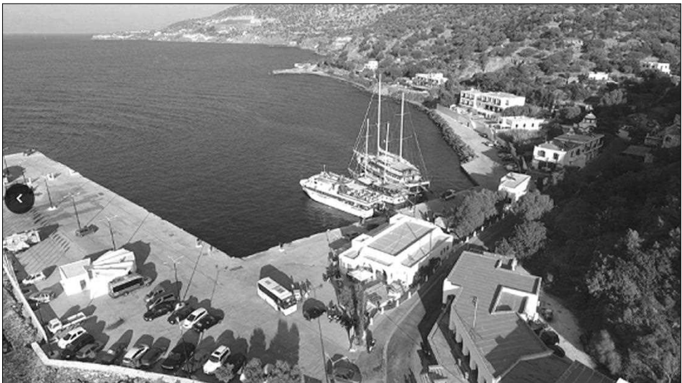
Το λιμάνι στο Μανδράκι όπως είναι σήμερα. Πίσω από το Διοικητήριο (το κτήριο δεξιά) είχαν ταμπουρωθεί οι κομάντος μαζί με τους Νισύριους συνεργάτες τους, ενώ τα γερμανικά πλοία είχαν παρβάλει στην προβλήτα.
